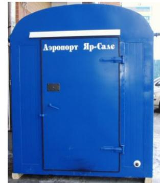
11. **Дизельный генератор ВЕПРЬ (Россия) 20 кВт** в контейнере северного исполнения (с подогревом) и автоматикой. **Выполнены:** Контейнер с естественной вентиляцией, комплектация и монтаж оборудования, щиты, жалюзи с электроприводами, дымоудаление, освещение и собственные нужды, электроотопление, пожаротушение, ПНР, тестирование. (Несколько единиц – для резервного электроснабжения магазинов, предприятий, коттеджей).
