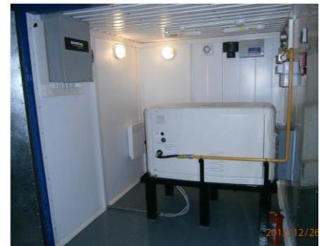
3. **Контейнерная электростанция SDMO (Франция) JS 100K/NEXYS мощностью 100 кВа** с автоматикой. **Выполнены:** Контейнер с естественной вентиляцией, комплектация и монтаж оборудования, щиты, жалюзи с электроприводами, дымоудаление, освещение и собственные нужды, электроотопление, пожаротушение, произведены ПНР, тестирование. (Пункт резервного электроснабжения предприятия Свердловской области).
