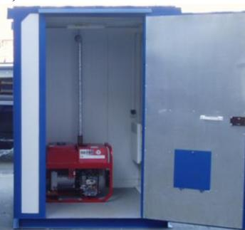
19. **Автоматический трёхфазный дизельный генератор ВЕПРЬ (Россия) 6,5 кВа АДП 6,5/3,2-Т400/230 ВЯ-БС с автоматикой БКА 25-117Е в утепленном контейнере антивандального исполнения, с подогревом, вытяжной вентиляцией, системами дымоудаления и автоматического и ручного пожаротушения, датчиком пожарной сигнализации, освещением и щитком собственных нужд. Проведено тестирование. Поставлена Заказчику в г.Пермь (октябрь, 2014г.) с помощью ТК для обеспечения резервного электроснабжения объекта.**
