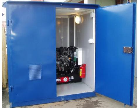
14. **Дизельный генератор KIPOR (КНР) 9,5 (8,5) кВт в кожухе и контейнере (с подогревом) и автоматикой. Выполнены:** Контейнер с естественной вентиляцией, комплектация и монтаж оборудования, щиты, жалюзи с электроприводами, дымоудаление, освещение, собственные нужды, котел подогрева ОЖ на дизельном топливе, ОПС, пожаротушение, ПНР, тестирование. (Резервное электроснабжение базы отдыха в Свердловской области).
