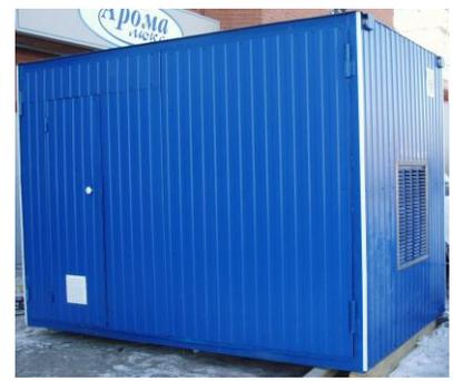
5. **Контейнерная автоматическая электростанция CRR-100GF (КНР)** мощностью **100 кВт** в исполнении в кожухе с двигателем **Ricardo** с автоматикой **Tehkam** (Россия). **Выполнены:** Контейнер с естественной вентиляцией, комплектация и монтаж оборудования, щиты, жалюзи с электроприводами, дымоудаление, освещение и собственные нужды, электроотопление, система ОПС и пожаротушения, ПНР, тестирование. (Резервное электроснабжение строящегося детского сада в Свердловской области), октябрь 2015г.
