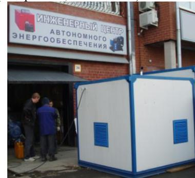
12. **Контейнерная ДГУ CRR50GF (КНР) 50 кВт** с автоматикой автозапуска и останова. **Выполнены:** Контейнер с естественной вентиляцией, комплектация и монтаж оборудования, щиты, автоматика запуска и останова, жалюзи с электроприводами, дымоудаление, освещение и собственные нужды, электроотопление, пожаротушение, произведены ПНР, тестирование. (Пункт резервного электроснабжения в одном из поселков Свердловской области).
