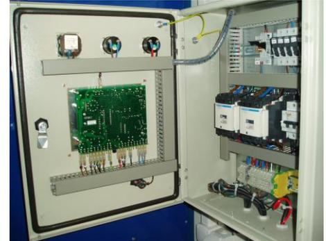
2. **Газогенератор Generac 5914 (США) 8 кВа с AVR RTSI 100 M3 в контейнере** (с подогревом) и автоматикой. **Выполнены:** Контейнер с естественной вентиляцией, комплектация и монтаж оборудования, газовая линия с комплексом приборов газовой защиты, щиты, жалюзи с электроприводами, вентилятор, дымоудаление, освещение и собственные нужды, электроотопление, пожаротушение, пожарная сигнализация, ПНР, тестирование. (Коттедж в г. Сысерть Свердловской области).
