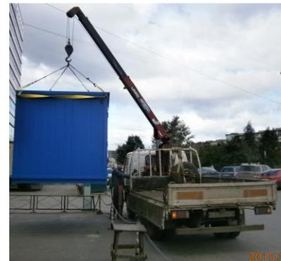
10. **Контейнерная ДГУ SDMO (Франция) T20HK/NEXYS 20 кВт** с автоматикой запуска и останова. **Выполнены:** Контейнер северного исполнения с естественной вентиляцией, комплектация и монтаж оборудования, щиты, жалюзи с электроприводами, дымоудаление, освещение и собственные нужды, электроотопление, пожаротушение, произведены ПНР, тестирование. (Пункт резервного электроснабжения аэропорта Яр-Сале).
