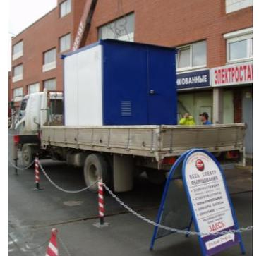
15. **Дизельный генератор ВЕПРЬ (Россия) 13,5 кВа в контейнере с (подогревом) и автоматикой. Выполнены:** Контейнер с естественной вентиляцией, комплектация и монтаж оборудования, щиты, жалюзи с электроприводами, дымоудаление, освещение, собственные нужды, котел подогрева ОЖ на диз. топливе, ОПС, пожаротушение, ПНР, тестирование. (Резервное электроснабжение месторождения в районе г.Н.Уренгой).
