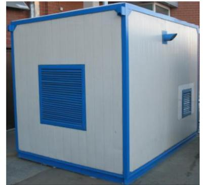
13. **Дизельный генератор ВЕПРЬ (Россия) 13,5 кВа в контейнере с (подогревом) и автоматикой. Выполнены:** Контейнер с естественной вентиляцией, комплектация и монтаж оборудования, щиты, жалюзи с электроприводами, дымоудаление, освещение и собственные нужды, котел подогрева ОЖ на диз. топливе, ОПС, пожаротушение, ПНР, тестирование. (Пункт резервного электроснабжения узла связи предприятия связи Свердловской области).
